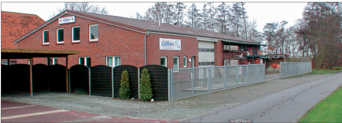
Die Halle in Dornumergrade soll künftig als Bauhof genutzt werden.
