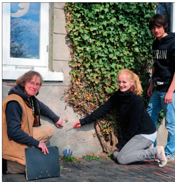
Monumentendienst-Mitarbeiterin Heike Notz zeigt Sophie Runge (16 Jahre) und Bas de Ree (17) versteckte Mauerschäden an dem alten Bauernhof aus dem 17. Jahrhundert.
