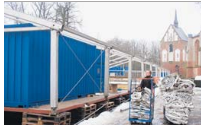
Die Planen der Norder Schöfelbahn wurden gestern abgenommen. Sie wurden ordentlich zusammengerollt und werden jetzt gelagert.
