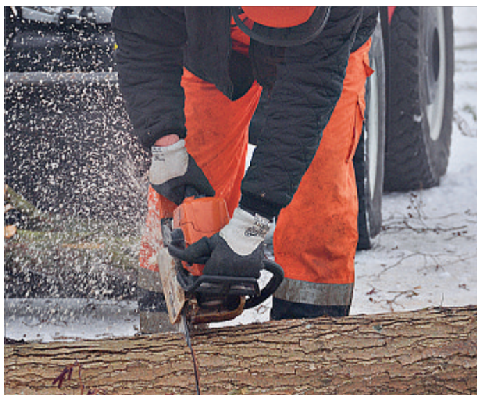
Die vorbereitenden Arbeiten sind angelaufen. Die Holtriemer Politik ebnete Montagabend mit dem Beschluss den Weg.
